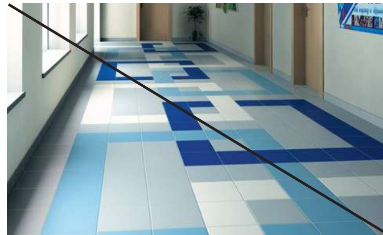
Плохо Цветные вставки из плитки
